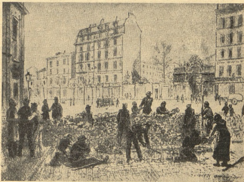
Budowa barykady 19 marca 1871 r.
