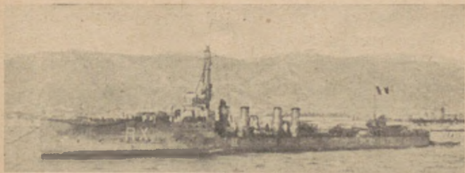
Francuski kontr-torpedowiec „Enseigne Roux” budowy 1915 r. wyporność 787 ton, szybkość 30 węzłów, moc maszyn 17.000 HP, uzbrojenie: 2-100 m/m, 1-75 m/m płt, 4-65 m/m, 4 wy- rzutnie torpedowe
