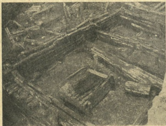
Resztki domów odkopanych w grodzie pod Santokiem
