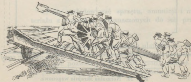
Ryc. 27. Wtaczanie na platformę działa lekkiego.
