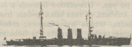
Lekki krążownik włoski Ancona (dawny niemiecki Graudenz ). Wyporność 4900 tonn. Szybkość 26 węzłów. Uzbrojenie 7 dział 150 mm.
