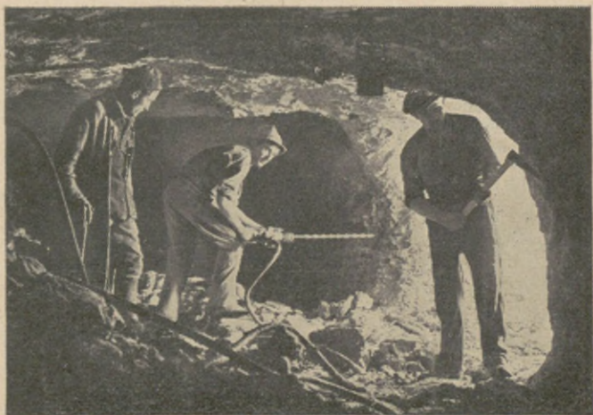
PRACA W KOPALNI SOLI POTASOWEJ W STEBNIKU, ŚWIDROWANIE, KOPANIE (Photo-Plat).
