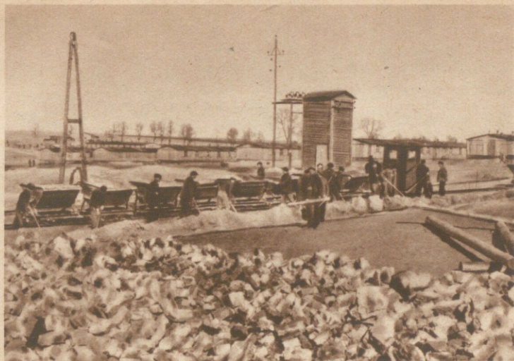
Fundament pod jeszcze jeden barak.
