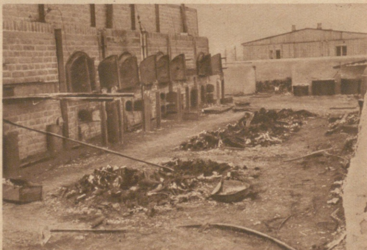
Pięć pieców nowoczesnego krematorium.
