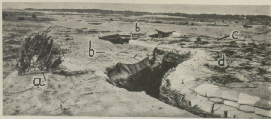
RYS. 28. Zdjęcie naziemne rowów strzeleckich. Przedmioty maskowane: a) punkt obserwacyjny, b) wnęk strzelecki, c) rów łącznikowy, d) ziemia świeżo wydobyta (urobek).
