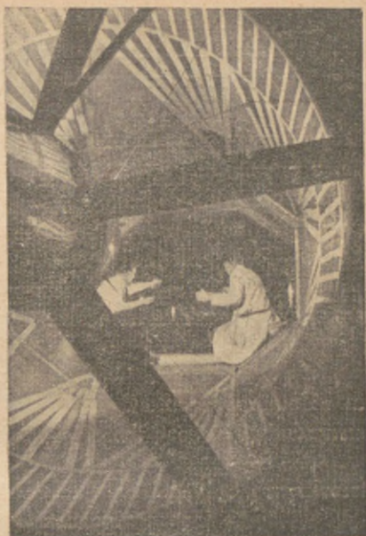
Nowoczesny tunel aerodynamiczny
