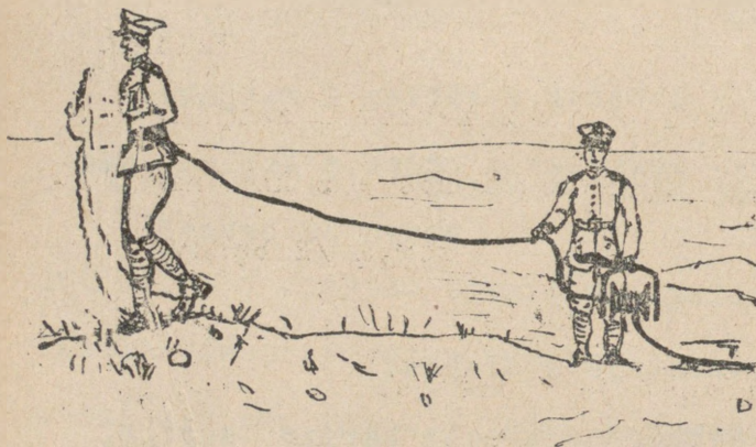
Rys. 52. Budowa linii z podkówkami.
