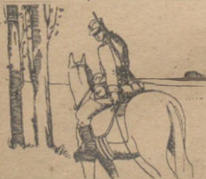
Rys. 82. Rozwijanie kabla konno.
