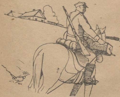
Rys. 81. Rozwijanie kabla konno.
