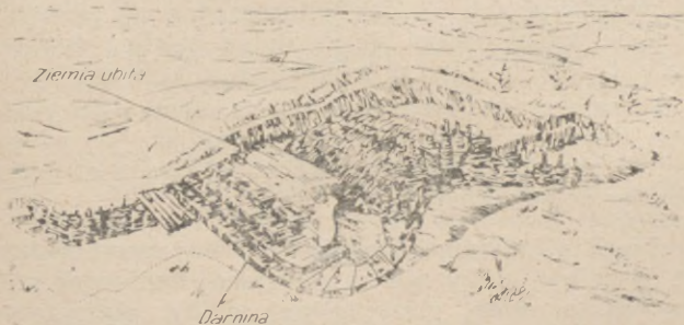
Rys. 142. Stanowisko z ubitej ziemi w czasie budowy
