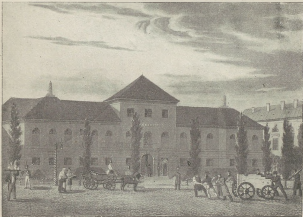
Widok zewnętrzny arsenału warszawskiego od ulicy Długiej w r. 1829.
