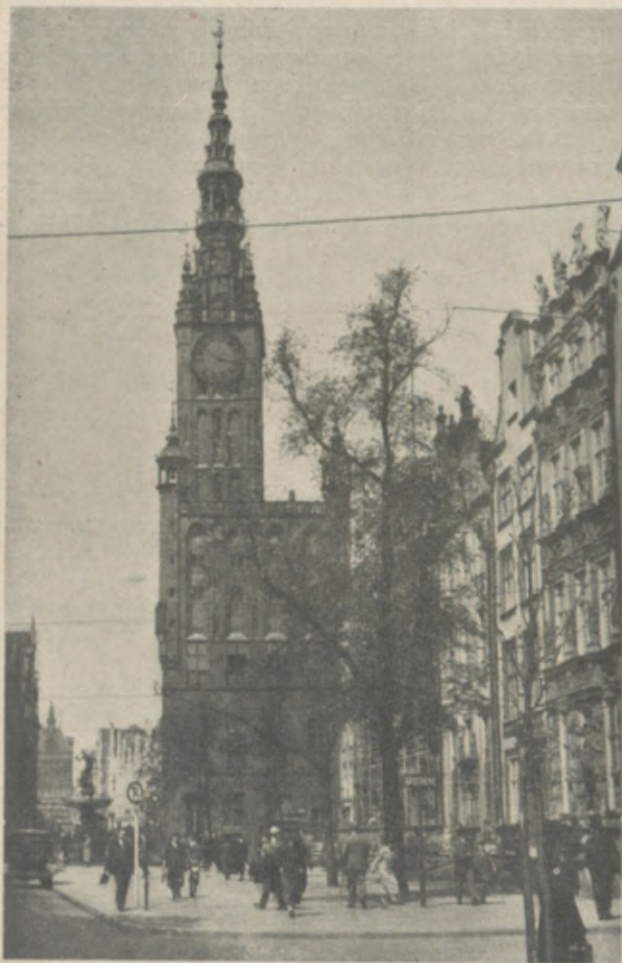
Ratusz gdański. Na szczycie 82 mtr. wieży, w r. 1561 ustawili mieszczanie gdańscy z wdzięczności za uzyskane przywileje statuę króla Zygmunta Augusta, wielszej niż naturalnej wielkości. Statua ta znajduje się na wieży do chwili obecnej.
