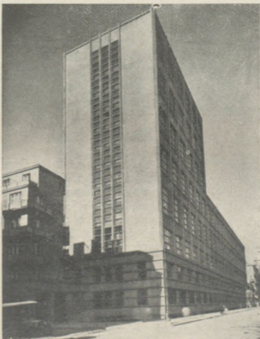
Centrala Telefonów międzymiastowych.
