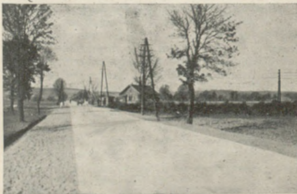
Nawierzchnie betonowe na drodze Cieszyn-Bielsko pod Skoczowem.
