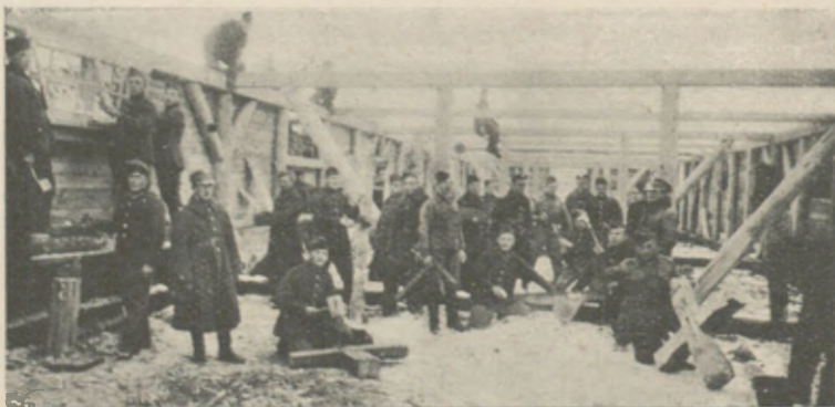
K. O. P. buduje własne pomieszczenia.
