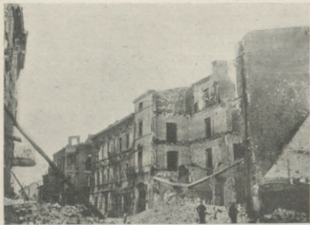
Kalisz zburzony, dawniej ul. Wrocławska
