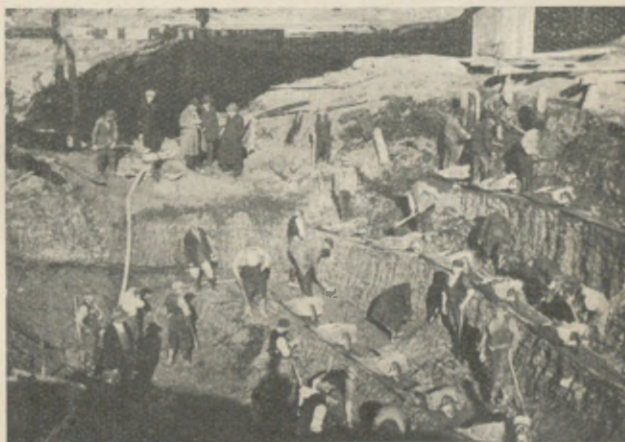
Regulacja Czarnej Przemszy. Wykop koryta pod mostem Mysłowice-Modrzejów.
