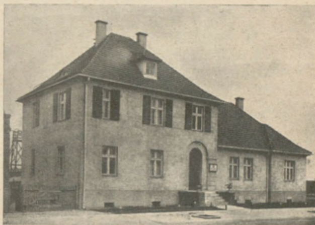
Nowy budynek posterunku P. P. w Gdyni.
