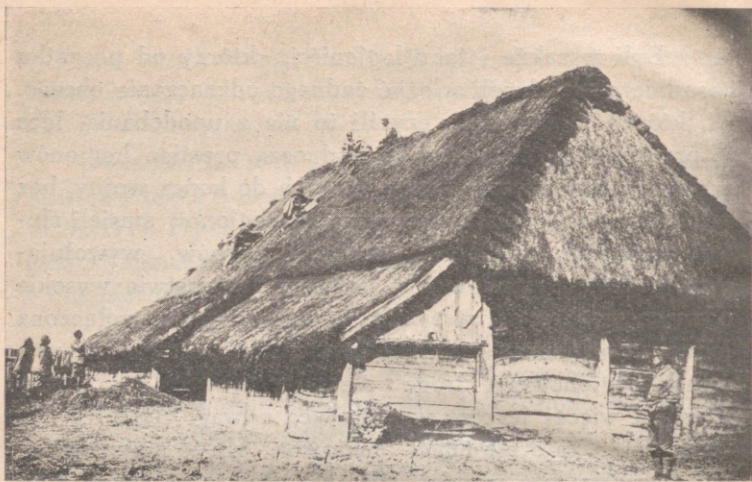
Ryc. 5. Rok 1915. — Punkt obserwacyjny baterji 5 pod Przepiórowem.
