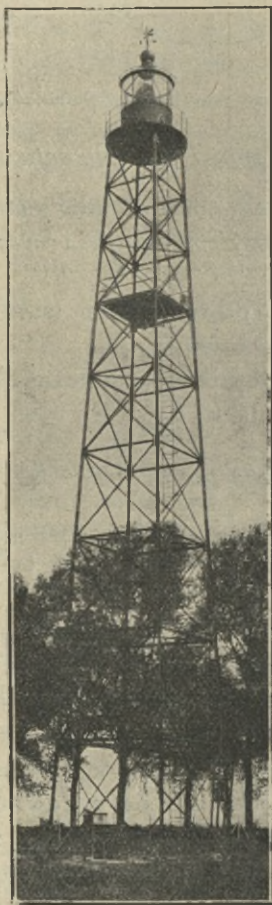
Rys. 2. Latarnia sygnałowa (à 4 éclats) syst. Barbier, Bénard i Turenne, ustawiona na lotnisku w Bourget.
