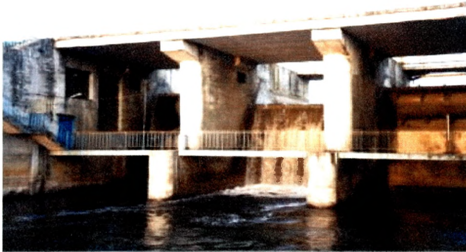
Zdjęci 14. Tama na sztucznym zbiorniku wodnym Siemianówka
